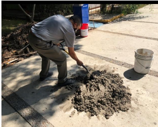
Figura No.2 Mezcla de concreto, resistencia mecánica de 150 \text{ kg/cm}^2
