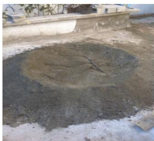
Figura No.1 Mezcla de arena fina, cemento tipo Portland y un agregado en base seca
