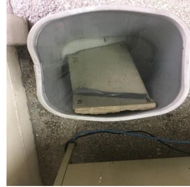
Figura No.5 Prueba de impermeabilidad
