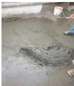
Figura No.2 Mezcla de arena fina, cemento tipo Portland y un agregado, en base húmeda
