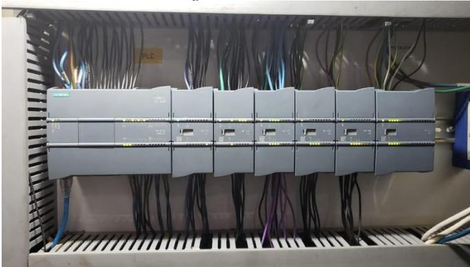
*Fig. 6 PLC Siemens 1200.*
